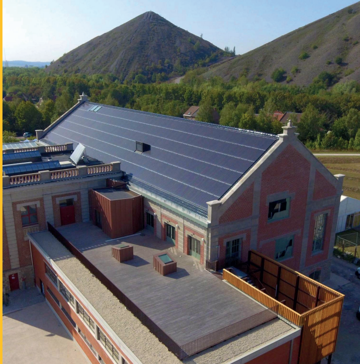
Réhabilitation de la salle des machines sur la Base 11/19 Installation de panneaux solaires par l'agglomération Lens Liévin permettant d'alimenter en électricité les bâtiments du site
